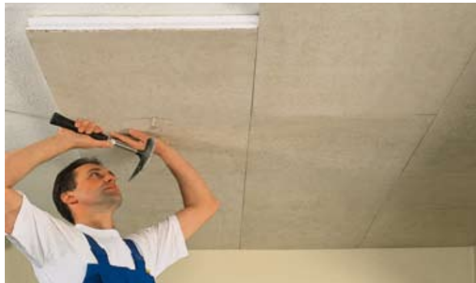
Heratekta E-37 035 für eine attraktive und wärmegeämmte Kellerdecke
