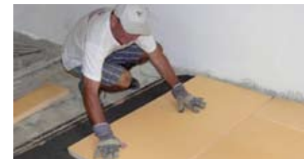
Schutzschild gegen Kälte von unten: Polyfoam C-350 SE
