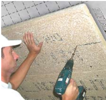
Dachausbau mit Heraklith BM-Platten
