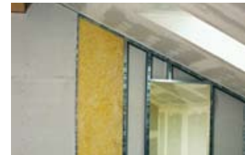
Dachausbau in Trockenbauweise
